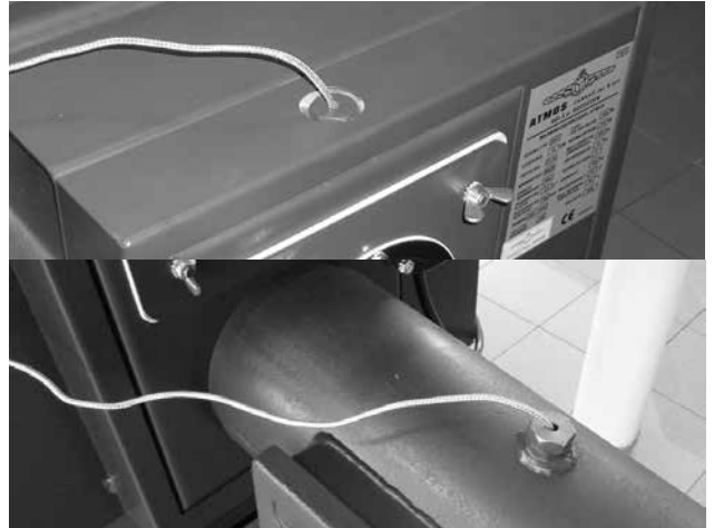
Abb. 14 - Ansicht auf Abgasfühler TS oder TSV im Schutzrohr des Rauchabzugs. Für Kessel D30P und D45P befindet sich auf des Rauchkanals
