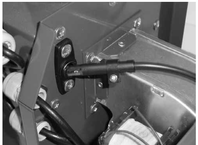
Abb. 4 - Photozelle - Vorsicht auf richtige Ori- entierung – es wird empfohlen, die Zelle mindes- tens einmal jährlich zu reinigen
