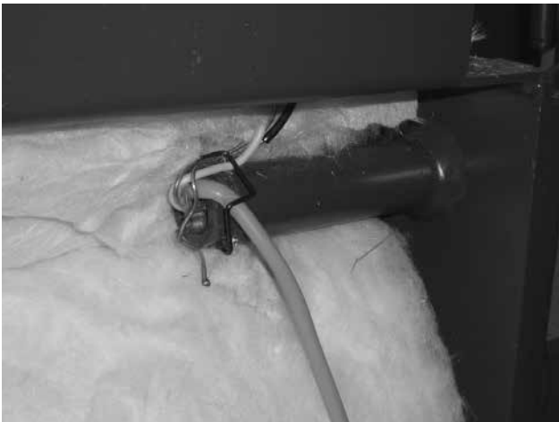
Abb. 15 - Ansicht des Wassertemperaturfühlers TK im Schutzrohr des Kessels DCxxSP(X)/(EP), CxxSP, KCxxSP oder des Kessels mit dem Brenner in Obertür DCxxS(X), CxxS(T), ACxxS, KCxxS, DCxxRS
