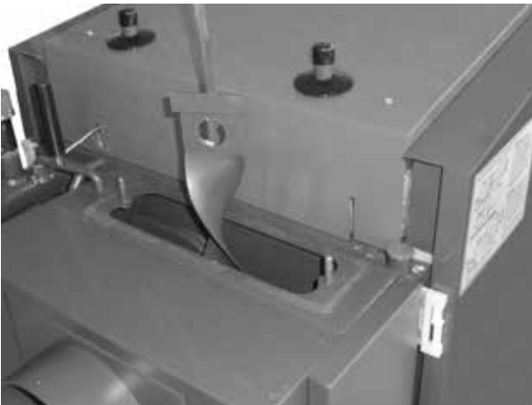
Den Turbulator bei der Reinigung herausnehmen
